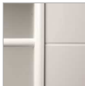
pohled na frézování
