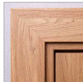
standardní spojování lišt pod úhlem 45°
